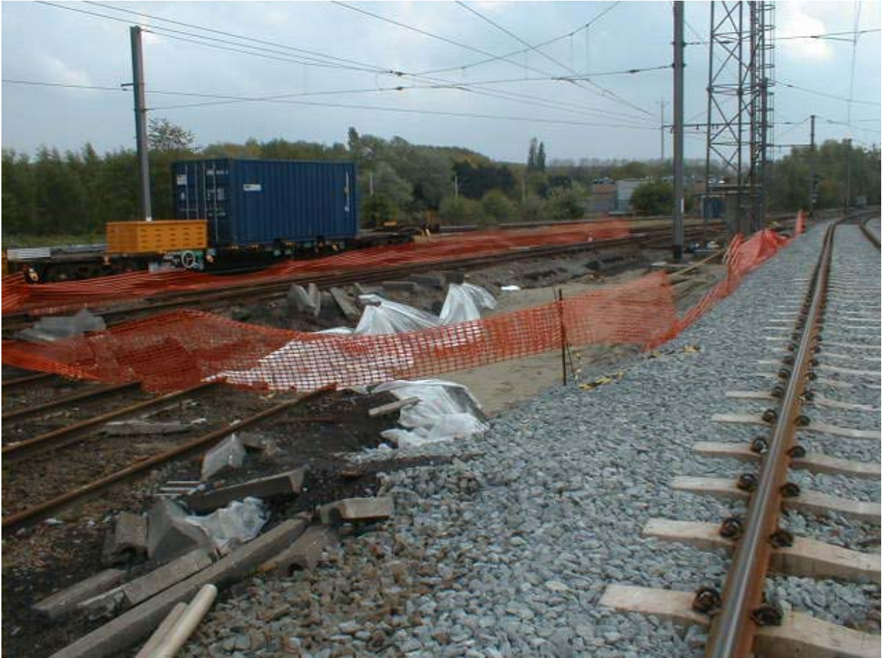
emplacement de l'accident, après enlèvement du sol pollué
