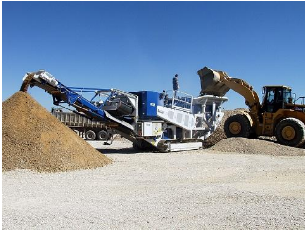
Mobiler Brecher im Einsatz
