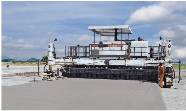
Gleitschalungsfertiger im Einsatz
