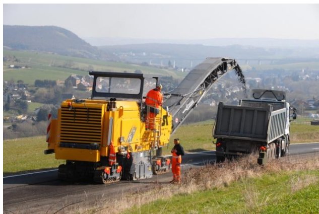
Großfräse im Einsatz
