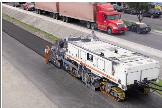
Kaltrecycler im Einsatz
