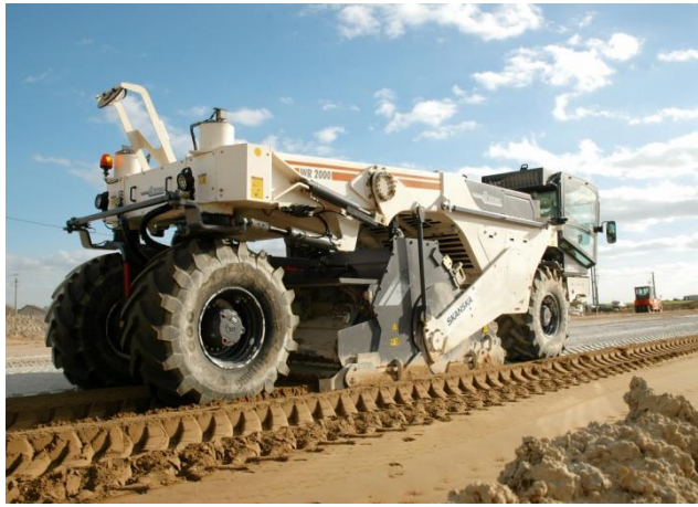
Kaltrecycler / Bodenstabilisierer im Einsatz
