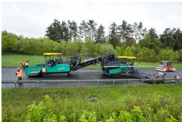
Beschicker, Asphaltfertiger und Gummiradwalze im Einsatz
