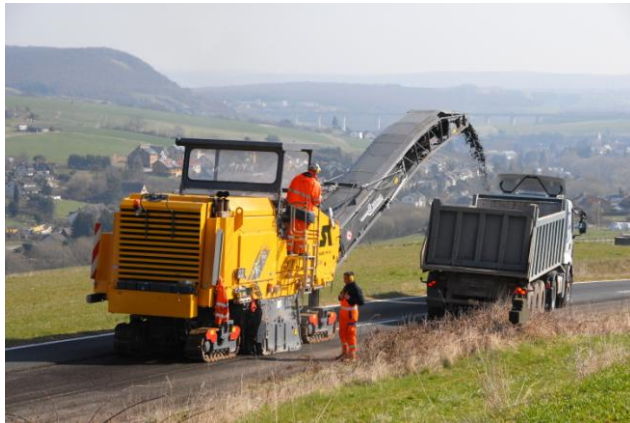
Großfräse im Einsatz
