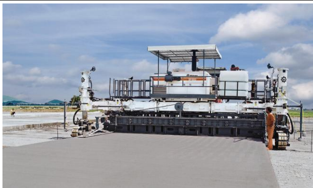
Gleitschalungsfertiger im Einsatz
