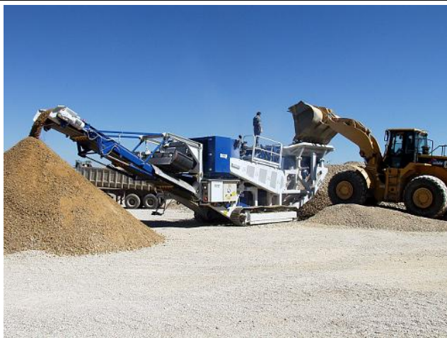
Mobiler Brecher im Einsatz
